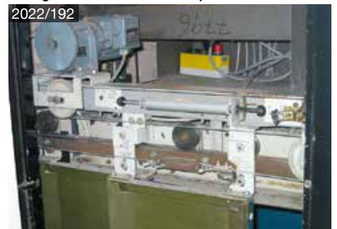
Rathgeber Drahtseil telescope
