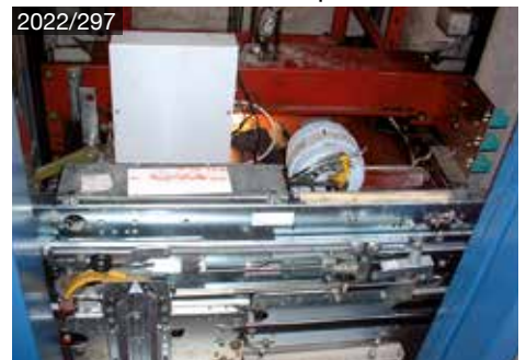
WITTUR 3201 Sinus telescope
