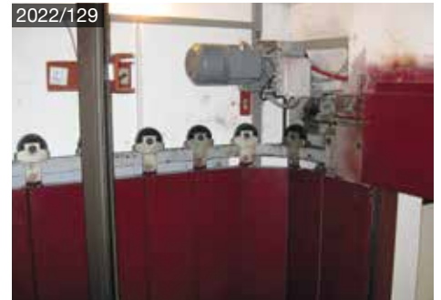
Meiller segment sliding door GTS6 central
